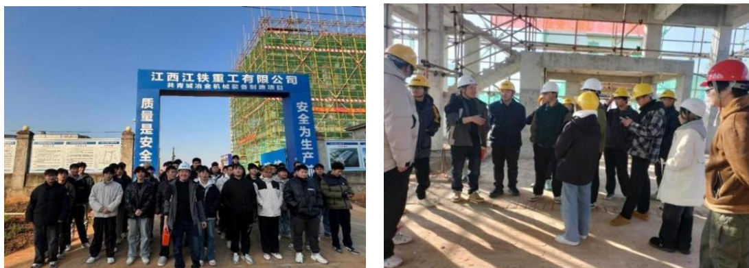
图 1-33 实践课程施工项目现场认知学习
